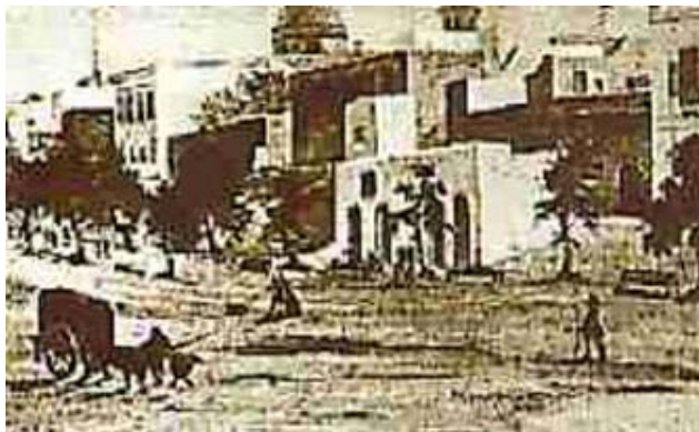
Edificio de la antigua Casa de Moneda donde a partir de 1614 había funcionado el Hospital y Ermita de San Martín.
