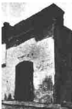
Entrada que fuera del hospital San Martín o de Santa Catalina (Archivo General de la Nación).
